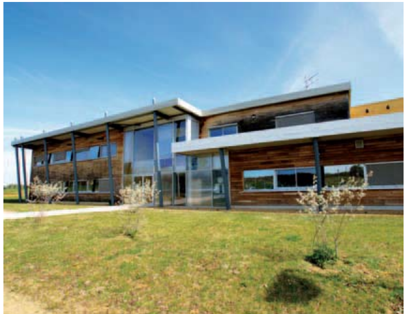
Pépinière d'entreprises du Nogaropôle
